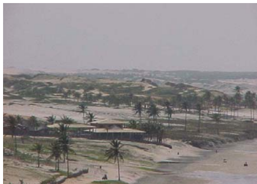
Figura DAS 04. Resort construído nas dunas da Praia da Lagoinha. Obra embargada. Indicação de pressão imobiliária e atividade turística desordenada
