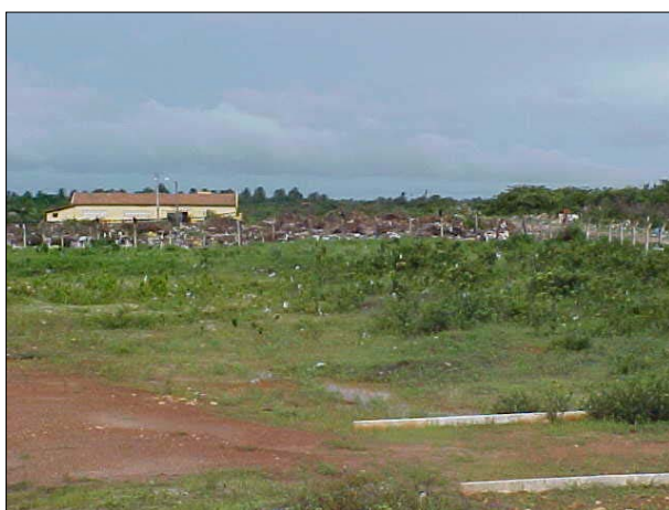
Figura DIB 83. Vista do lixão e abatedouro da Prefeitura
