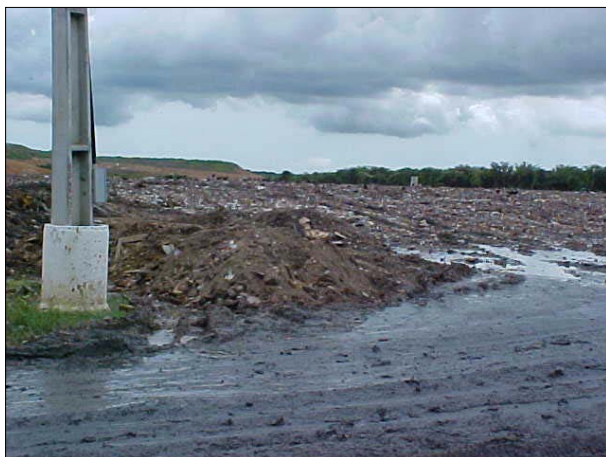
Figura DIB 63. Foto mostrando acúmulo de chorume em ponto baixo da pista de circulação do ASMOC
