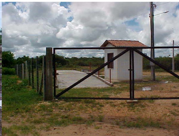
Figura DIB 98. Foto mostrando instalações do Aterro Sanitário de Camocim
