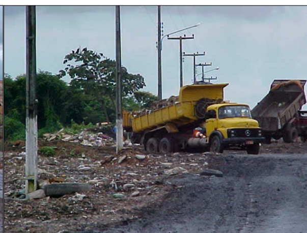
Figura DIB 62. Foto mostrando operação de caminhões tipo caçamba descarregando na trincheira do ASMOC
