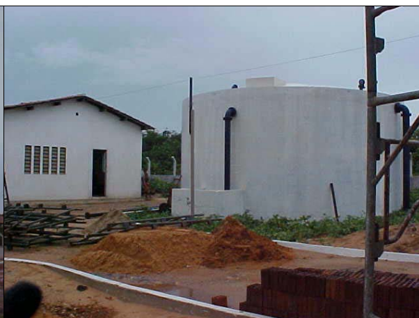
Figura AVP 07. Reservatório apoiado, em fase final de construção em Paraipaba através do PRODETUR CE I
